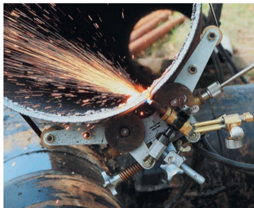
В ходе ремонта заменено более 400 метров трубы
