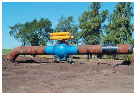
После внесения изменений в обвязку компрессорные станции смогут качать газ в обе стороны
