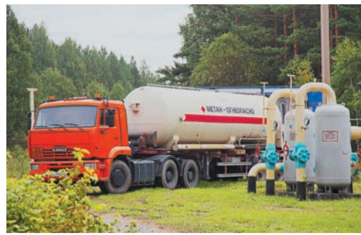
Газовый «аккумулятор» на ГРС-1 Асбеста
