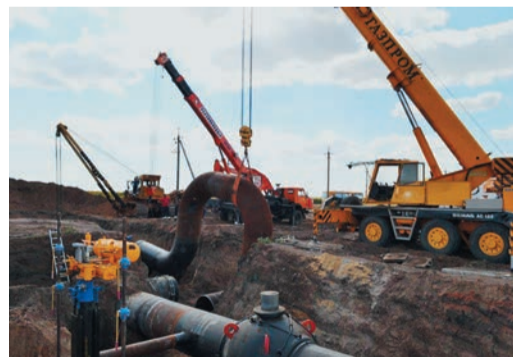
После внесения изменений в обвязку компрессорные станции смогут качать газ в обе стороны
