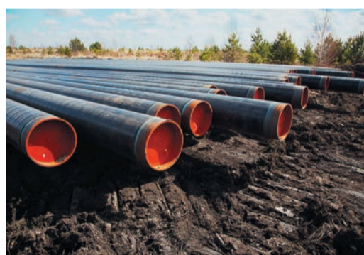
В ходе ремонтных работ будет переуложена значительная часть уфалейского отвода
