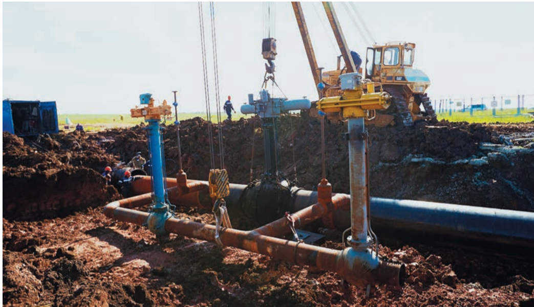
Монтаж нового кранового узла на «нуле» магнитогорского отвода стал самым сложным этапом комплекса подготовительных работ
