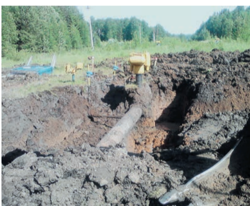
За летний сезон в Невьянске планируют отремонтировать четыре перемычки между МГ «Свердловск — Нижний Тагил» и МГ «СРТО — Урал»
