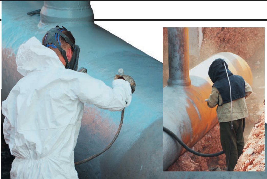
Каждый сантиметр выходных шлейфов тщательно очищают, прежде чем покрыть новой жаростойкой изоляцией
