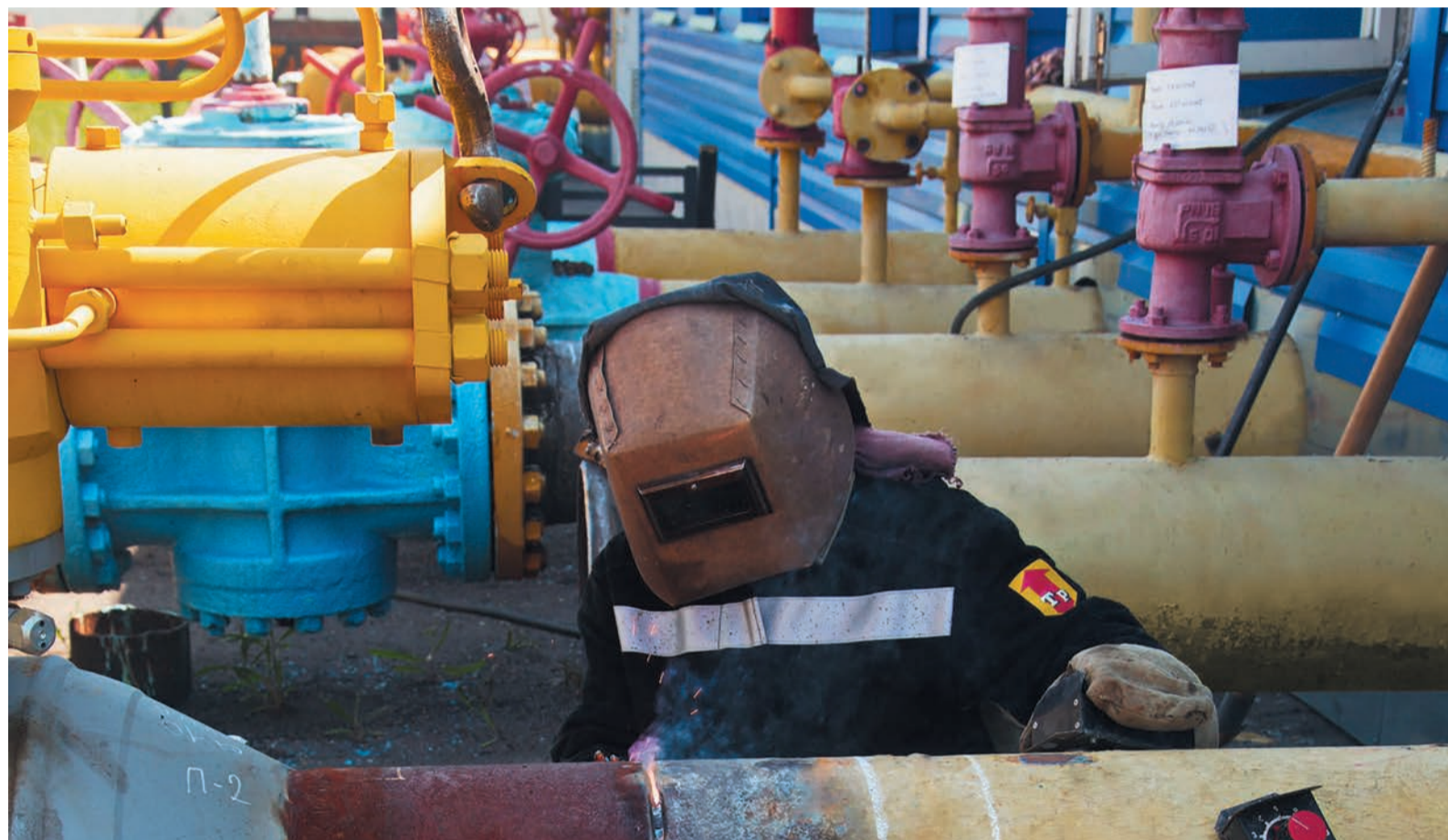
Сварщик УАВР-2 Раис Кутлузильдин вышел на пенсию, но сделанные им сварные стыки будут служить долго
