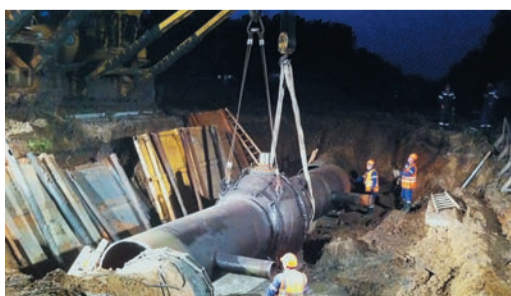
Летняя ремонтная кампания открылась крупным комплексом огневых работ на МГ «Уренгой — Челябинск»
