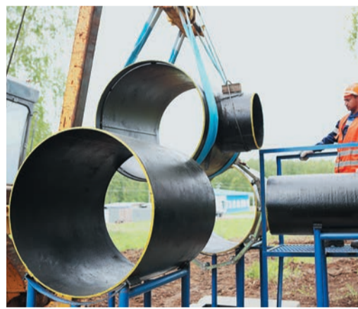
Одним из практических заданий традиционно был монтаж тройника
