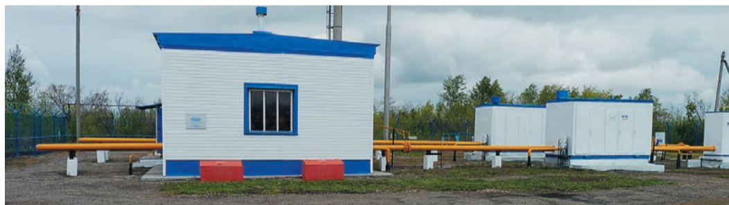
Входные краны на ГРС «Троицк» готовы к автономной работе
