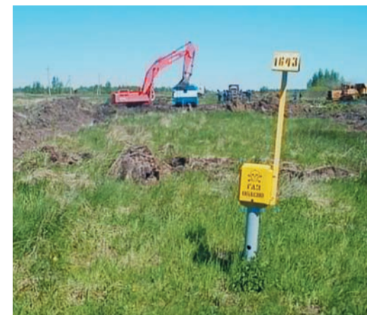
В Далматовском ЛПУ продолжается ремонт МГ «Уренгой — Челябинск»
