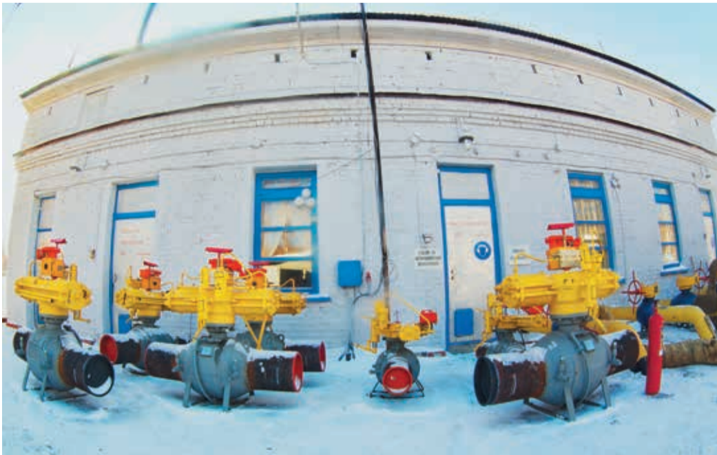
Новые краны окатушены, испытаны и подготовлены к установке
