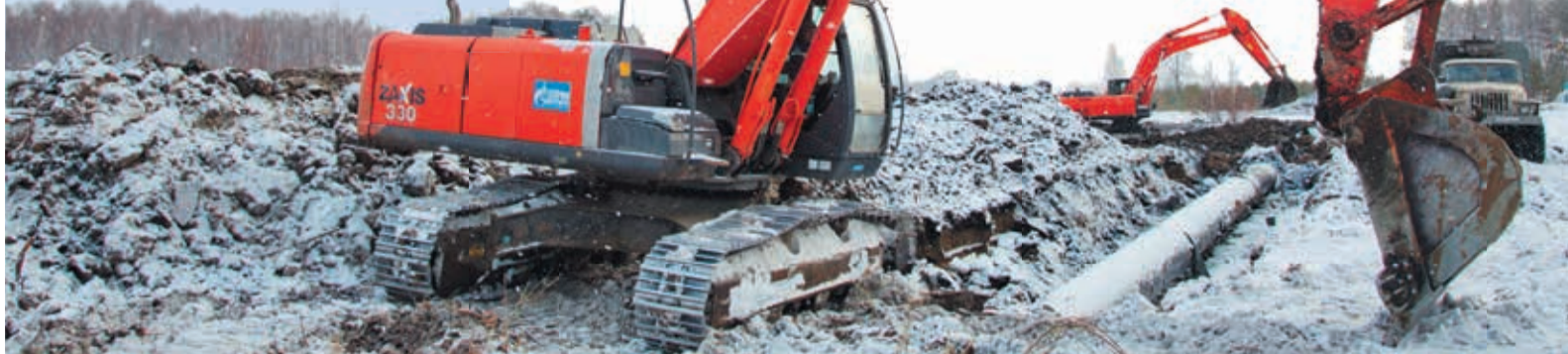
Экскаваторы Альтафа Фарахова и Василия Григорьева траншею подготовили — слово за изоляровщиками
