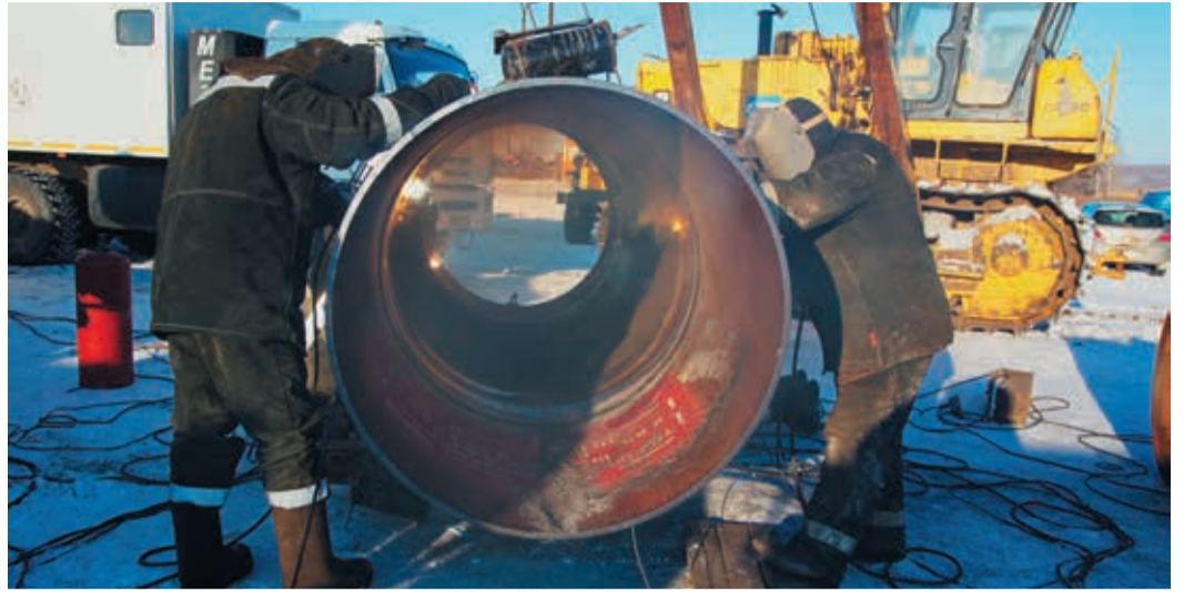
Остается приварить последнюю катушку, и тройник вернется в траншею
