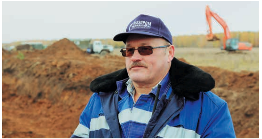
Главный инженер МИЛПУ С. В. Павлов на комплексе по ремонту газопровода-отвода к Каменск-Уральскому
