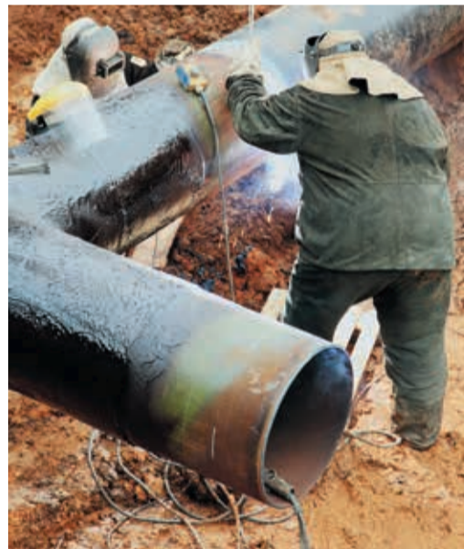
Первый стык нового кранового узла
