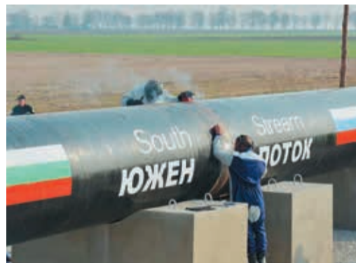
Сварка первого стыка газопровода «Южный поток» на территории Болгарии
