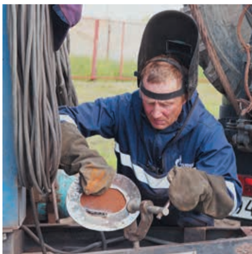
Ильнур Абсалямов готовит заглушку для технологического отверстия
