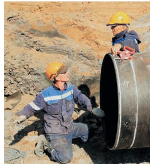
Олег и Василий Кирпичниковы размечают место установки катушки
