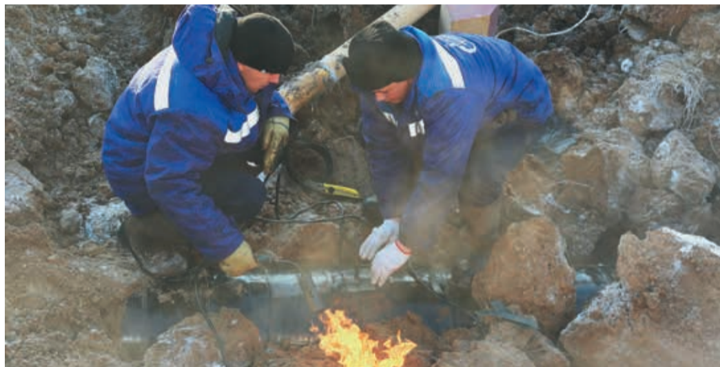
Заключительный этап изоляционных работ выполняют Андрей Кузнецов (слева) и Евгений Домашов
