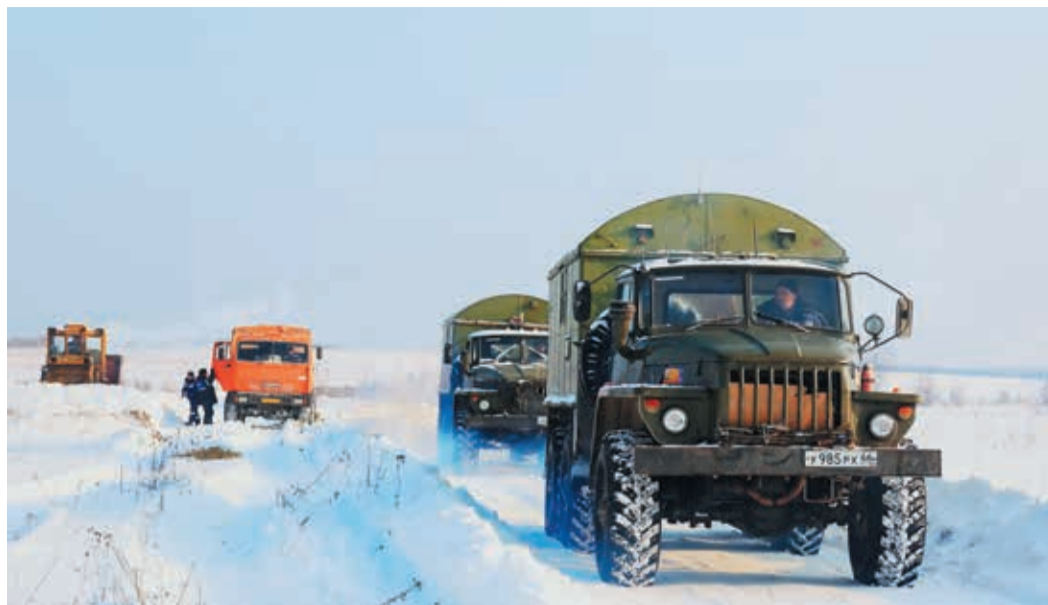
На этом участке ремонтные работы закончены: техника готова к переезду на следующий объект
