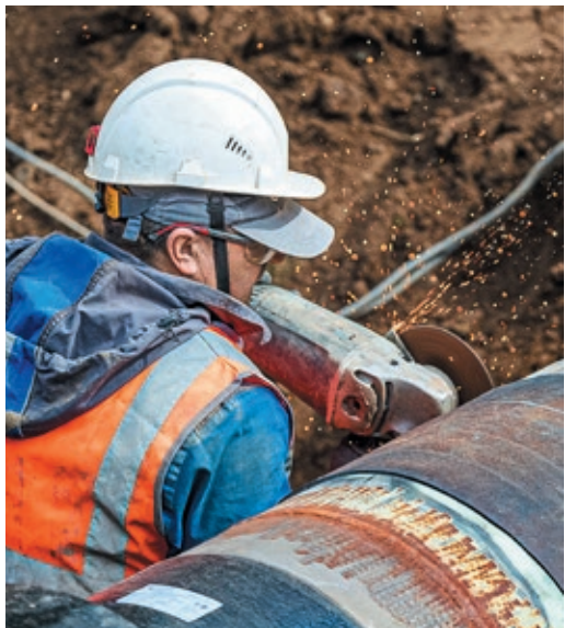
Монтажник работает в тандеме со сварщиком, зачищая шов и давая ему несколько минут отдыха
