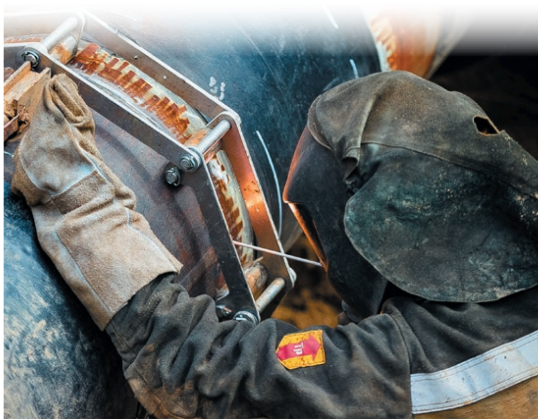
С точки зрения сварщика установка изолирующей муфты не отличается от монтажа обычной катушки
