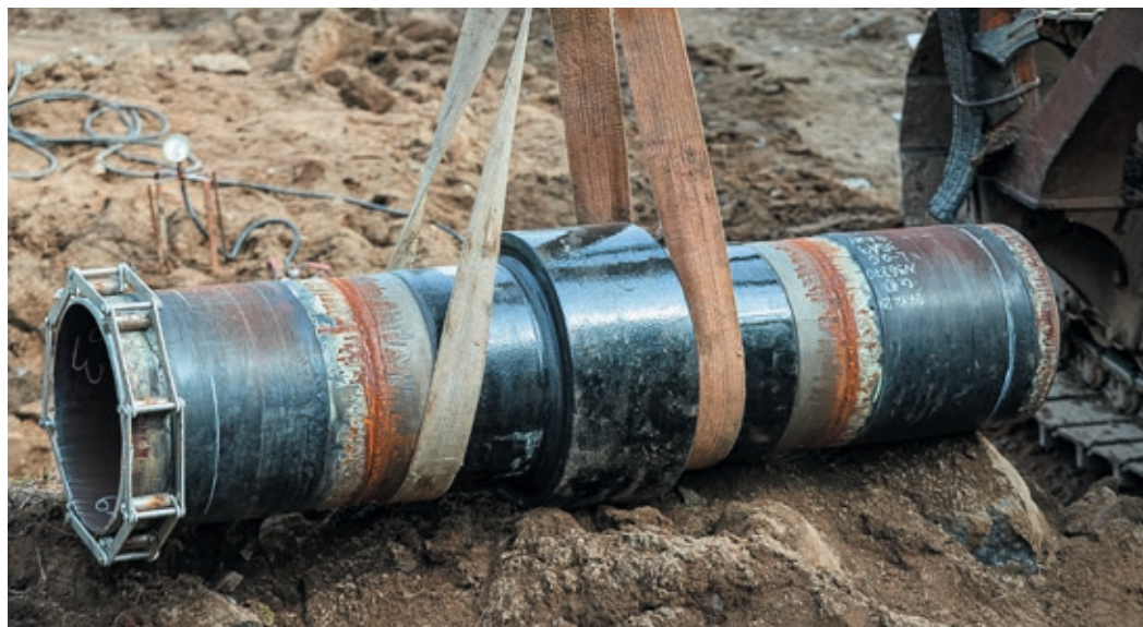
Чтобы не возникали скручивающие и изгибающие напряжения, электроизолирующую вставку сначала «окатушивают» с двух сторон, формируя плетель
