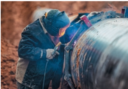
В Челябинском ЛПУМГ в ходе ремонта на МГ «Бухара — Урал» за год сохранили 2,2 миллиона кубометров газа
