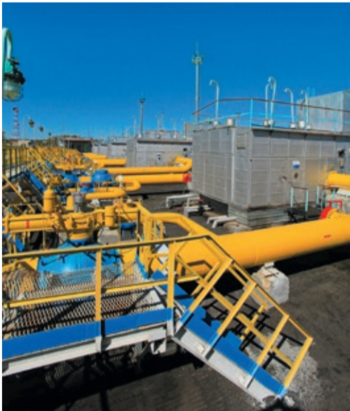
На КС «Красногорск» в 2024-м установили клапан-регулятор, предварительно выработав газ из технологического контура
