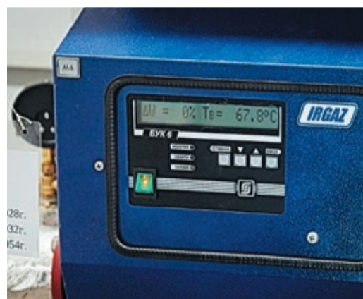
После капитального ремонта управление всей сложной «машинерией» ГРС переходит к центральному контроллеру, а главным рабочим инструментом оператора становится жидкокристаллический экран
