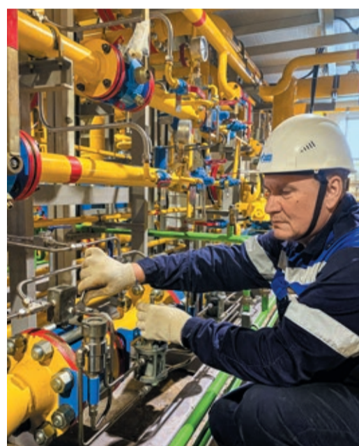
На станции в Карабаше продолжают пусконаладочные работы
