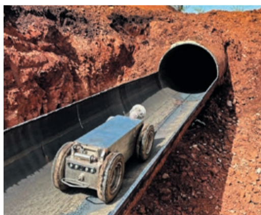
При протаскивании первым в жерло трубы отправляется колесный робот с тонким тросом
