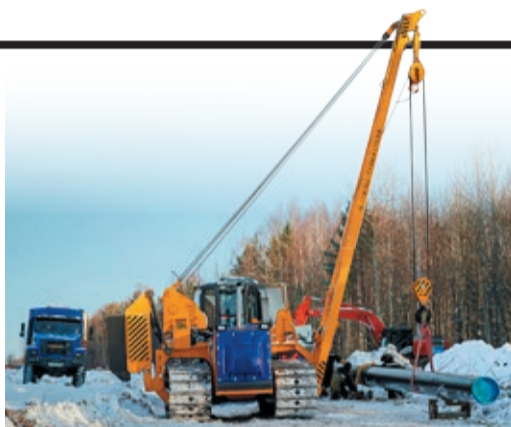
Салдинский отвод отремонтировали методом лупингования, уложив новую нитку рядом со старой
