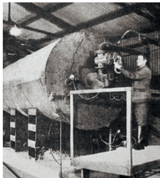
Фотографы запечатлели, как заканчивается наладка новой установки по производству удобрений
