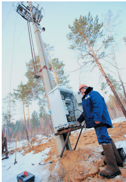
В Трансгазе повсеместно внедряются новые технологии: в МИЛПУ идет установка СКЗ
