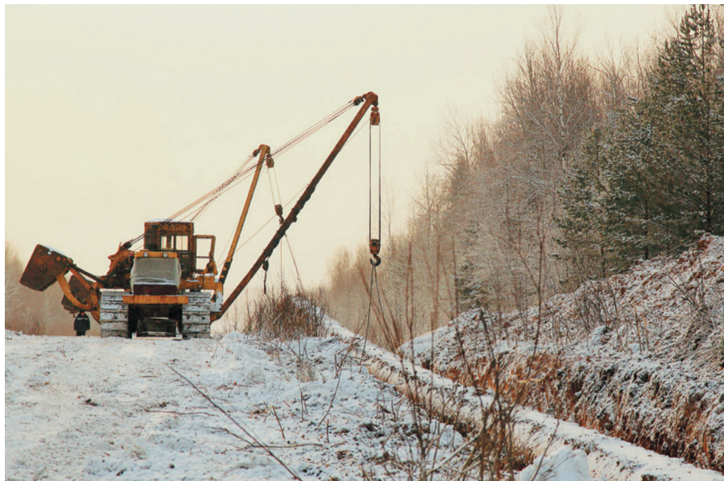
На участке МГ «СРТО — Урал II» выполняется демонтаж последних участков старой трубы
