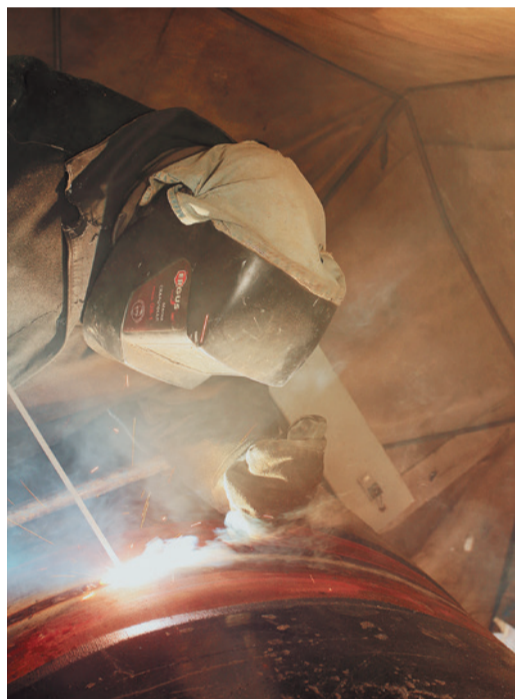
В ходе ремонта сварщики сделали почти 800 стыков на трубе 1200 мм
