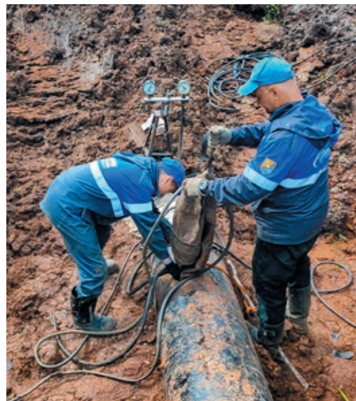
Безопасность огневых работ обеспечивали сотрудники Невьянского филиала
