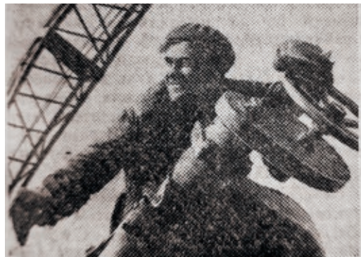
Строители газопровода Бухара—Урал достигли конечного пункта — города Свердловска. На снимке: бригадир Василий СИМАНОВ заканчивает монтаж задвижки на распределительном узле в районе завода «Уралэлектротяжмаш».
