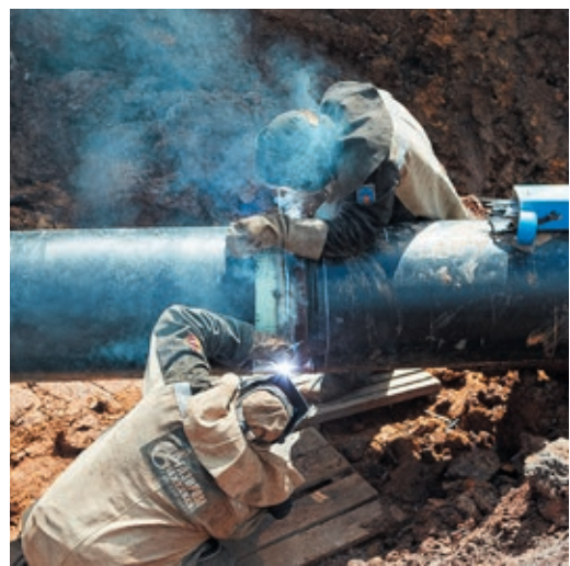
Подключали готовый участок работники УАВР № 3
