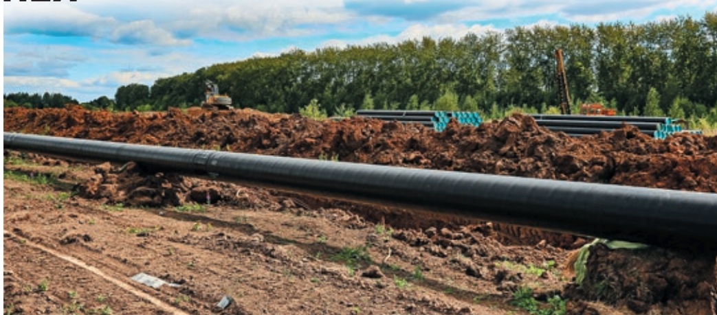
Новый лупинг тянули вдоль трассы действующего газопровода
