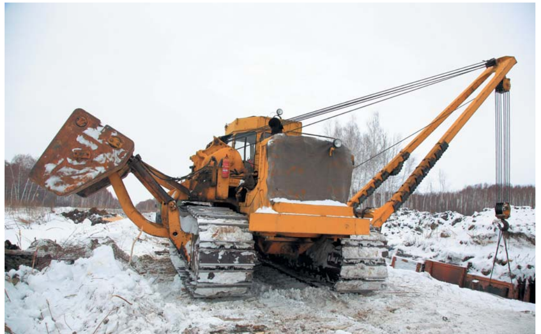
Сергей Аликин подает новую трубу, предусмотрительно поставив машину подальше от края траншеи
