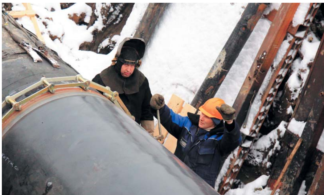
По сигналу Андрея Петрова труба опускается на считанные миллиметры
