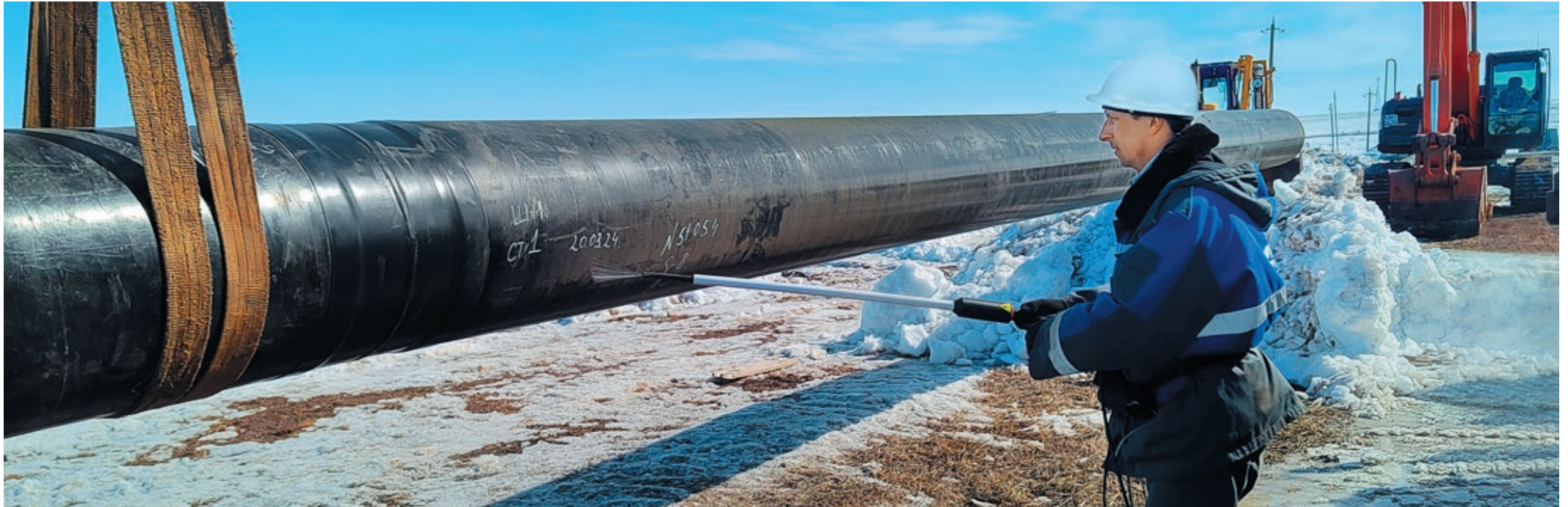
Сотрудник лаборатории неразрушающего контроля УАВР № 2 Евгений Дурасов перед укладкой трубы в траншею проверил качество изоляции искровым дефектоскопом
