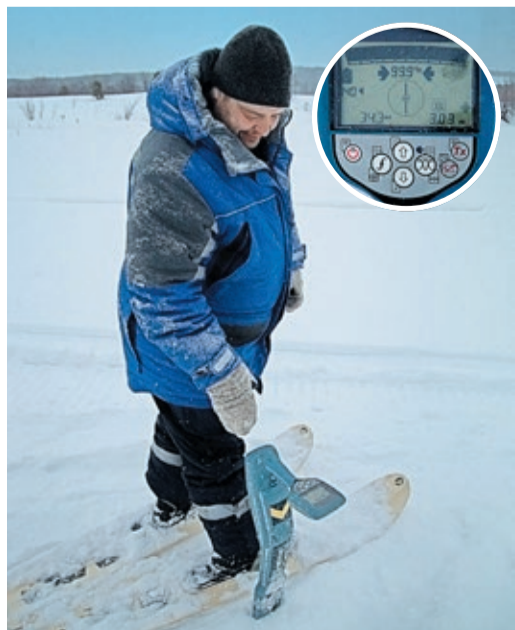
Трассоискатель «видит» трубу даже на глубине 30 метров
