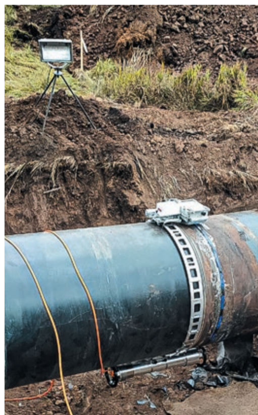
Дефектоскописты УАВР № 4 использовали «Транскан» на четырех магистральных газопроводах
