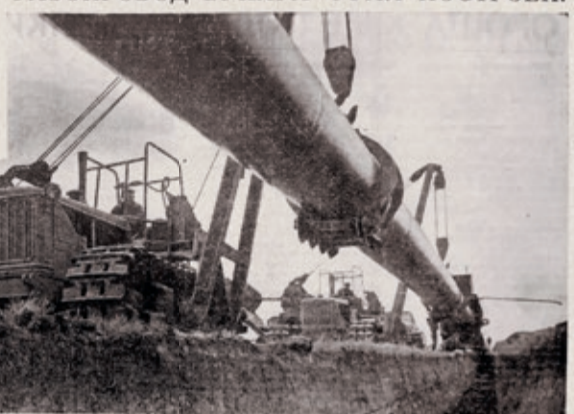
ТАК ПРОВОЗИЛИСЬ УПАКОВКА ТРУБ НА ТРАССЕ ГАЗОПРОВОДА БУХАРА-УРАЛ.
