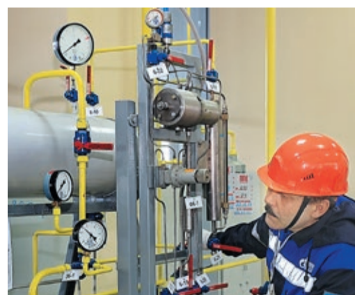
На любой ГРС или в котельной установлены десятки средств измерений, которые периодически проходят калибровку
