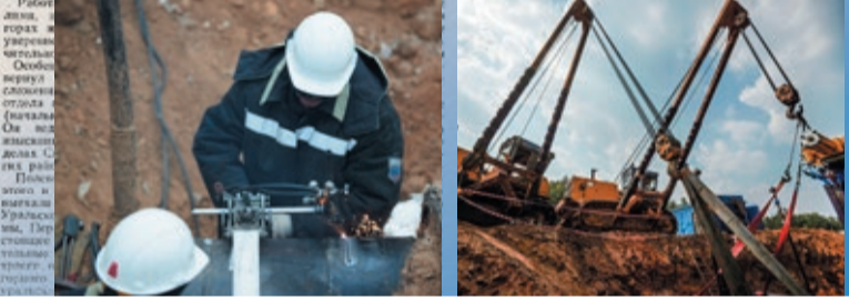
РАБОТЫ ПО СТРОИТЕЛЬСТВУ ГАЗОПРОВОДА БУХАРА-УРАЛ ОТЛИЧИЛИСЬ ИЗЫСКАТЕЛИ
