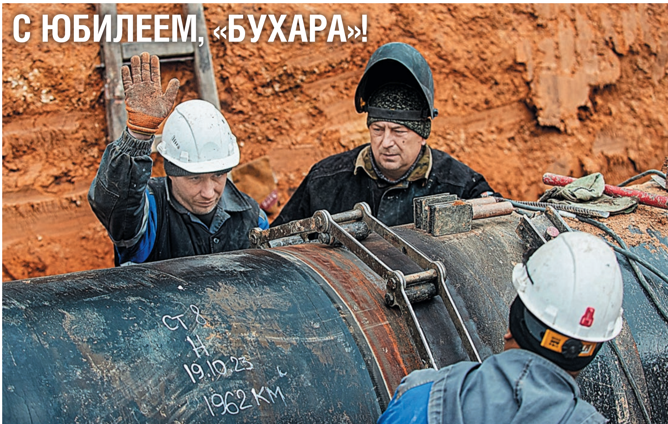
Залог успешного долголетия — восстановительные и омолаживающие процедуры. Бригада УАВР № 1 восстанавливает надежность 1 нитки магистралей
