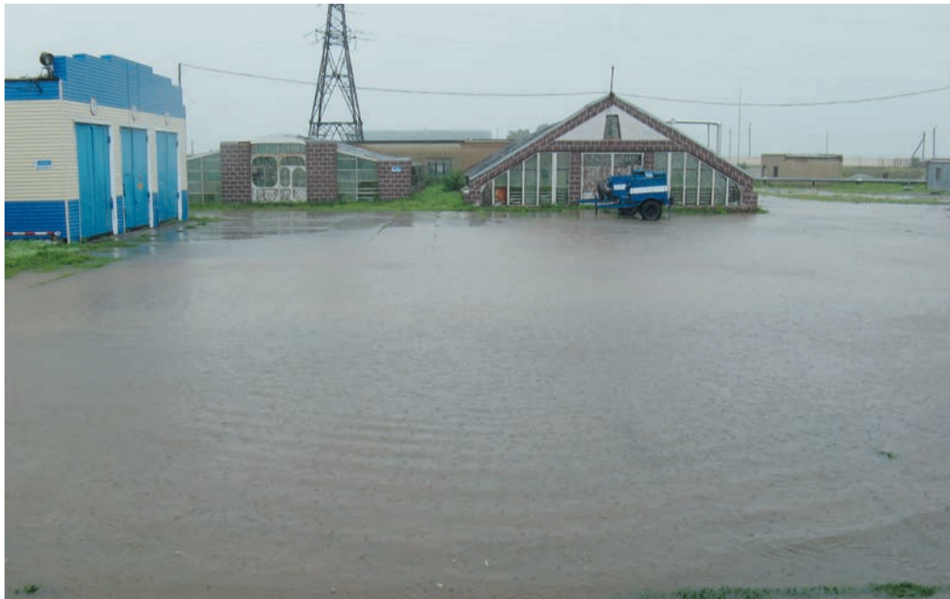
Промплощадка Карталинского ЛПУ практически полностью оказалась под водой
