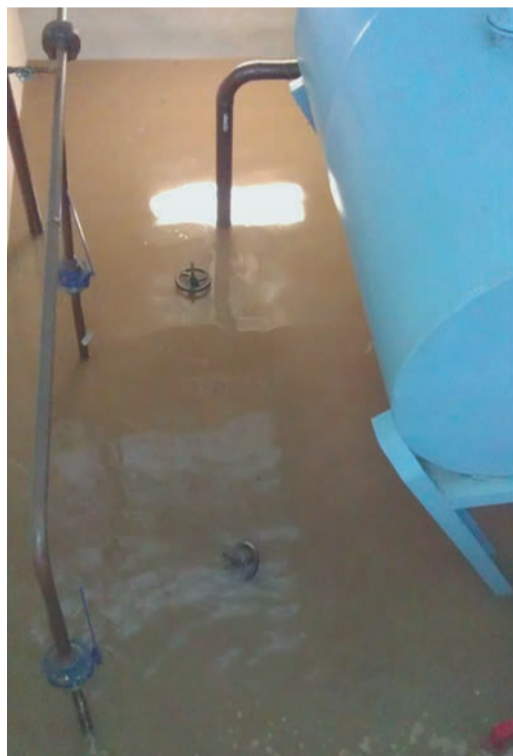
Прямки под ГПА в компрессорном цехе КС-17 до и после наводнения
