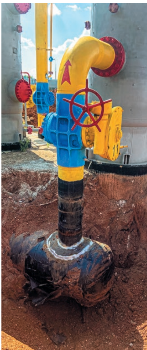
В Оренбурге дефектоскописты ИТЦ и УАВР № 4 проверили более 110 прямых врезок и тройников
