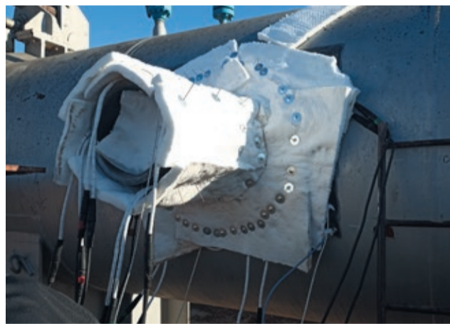
На улице было жарко, но под термоодеялом еще горячее: для снятия напряжения стык нагревали до 700 градусов
