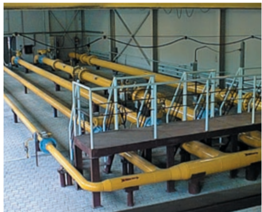
Измерительные трубопроводы первой очереди собрали бригады УАВР №1
