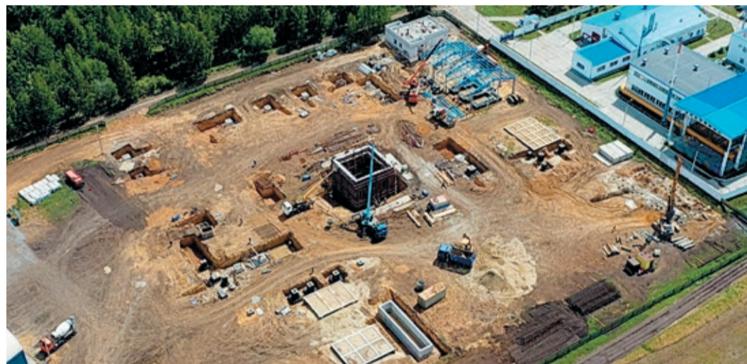
Полным ходом продолжается строительство третьей очереди УРМЦ
