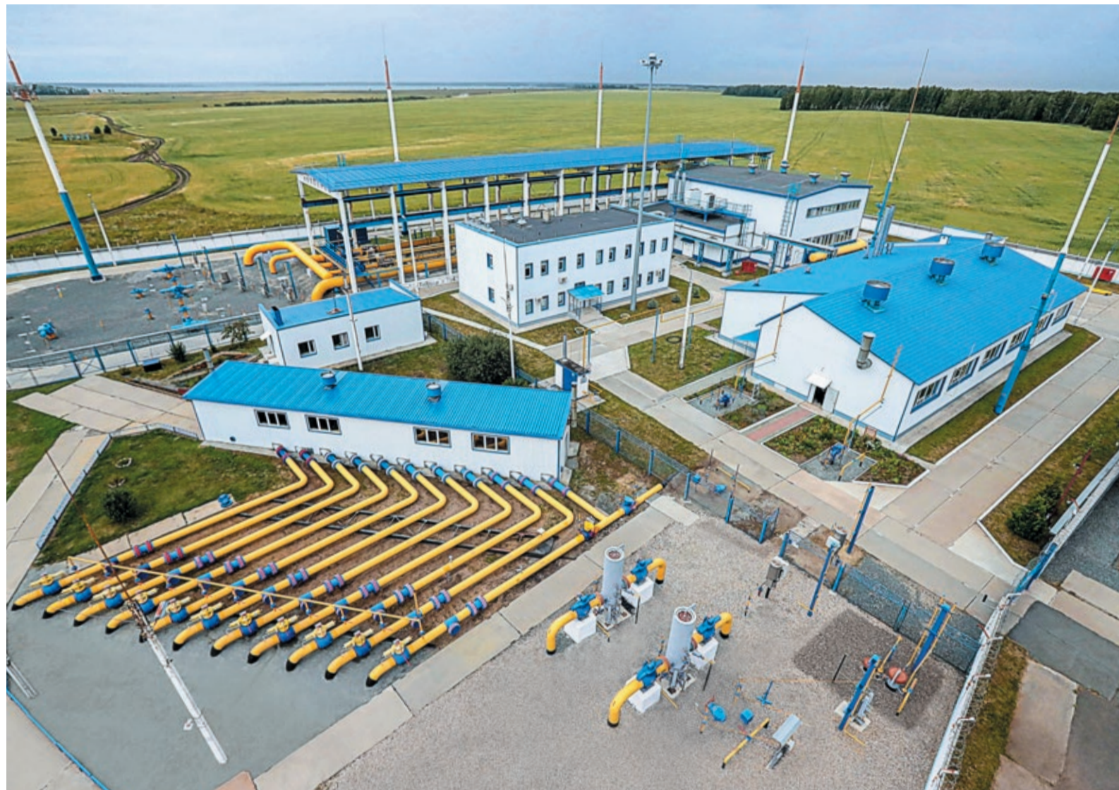
Уральский региональный метрологический центр — единственная в России площадка, где можно поверить и испытать газовые счетчики и расходомеры трубопроводным газом магистрального давления
