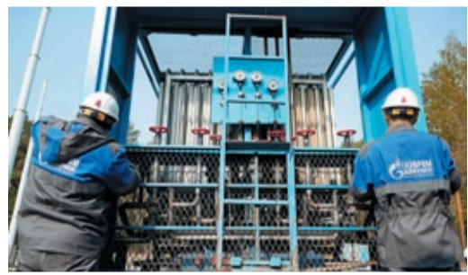
В регазификаторе метан из жидкого состояния переходит в газообразное
