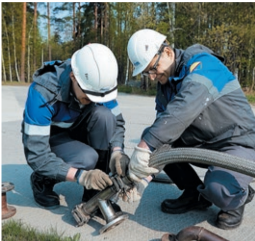
Операторов и слесарей ГРС научили собирать выходной трубопровод...
