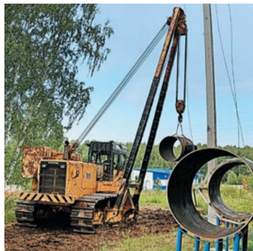
Самое трудное — монтаж тройника
