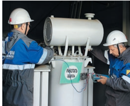
Специалисты ИТЦ испытывают силовой трансформатор в УАВР № 3
