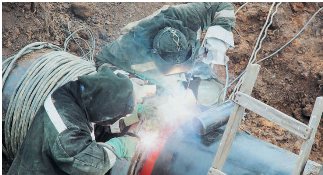
Благодаря слаженной работе УАВРовцев весь комплекс огневых работ удалось выполнить за 17 часов
