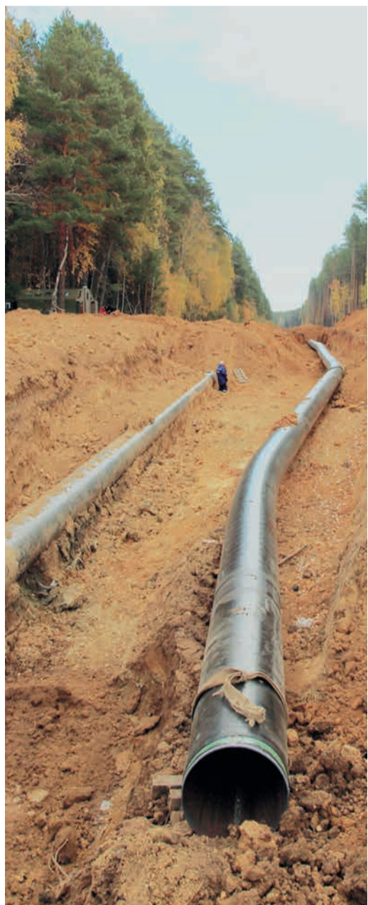
Две трубы: одна — порывевшая от времени, другая — в черной заводской изоляции
