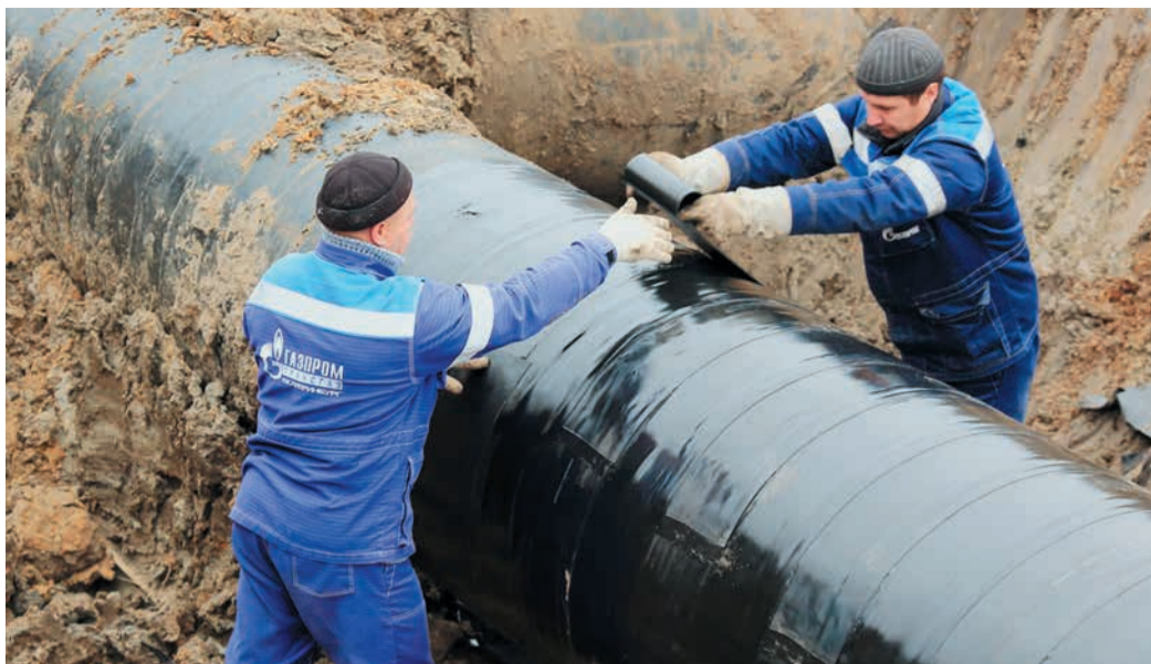
Изолировщики Шадринского участка УАВР-3 в ходе ремонтных работ на выходном шлейфе КС «Шатровская»
