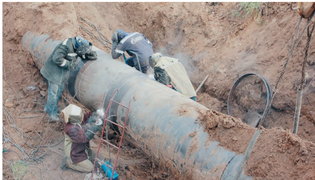
Бригада Олега Парфенова выполняет ремонт дефектного участка газопровода «Бухара — Урал»
