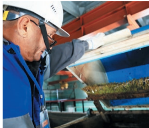
Осмотр щеток барабанного сита на блоке механической очистки
