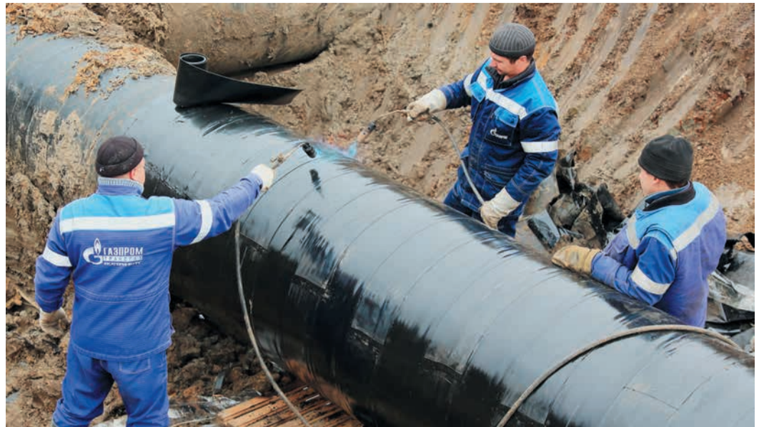
Изолировщики УАВР-3 Сергей Колчин и Иван Некрасов наносят последние витки изоляции перед подключением восьмого шлейфа
