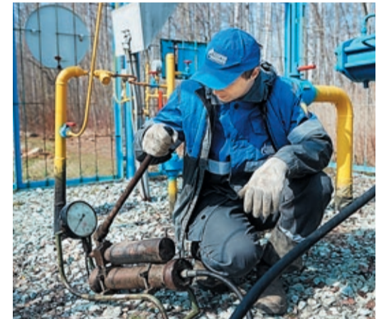
Диаметр небольшой, поэтому уплотнительную пасту Кирилл Калнин набивает быстро
