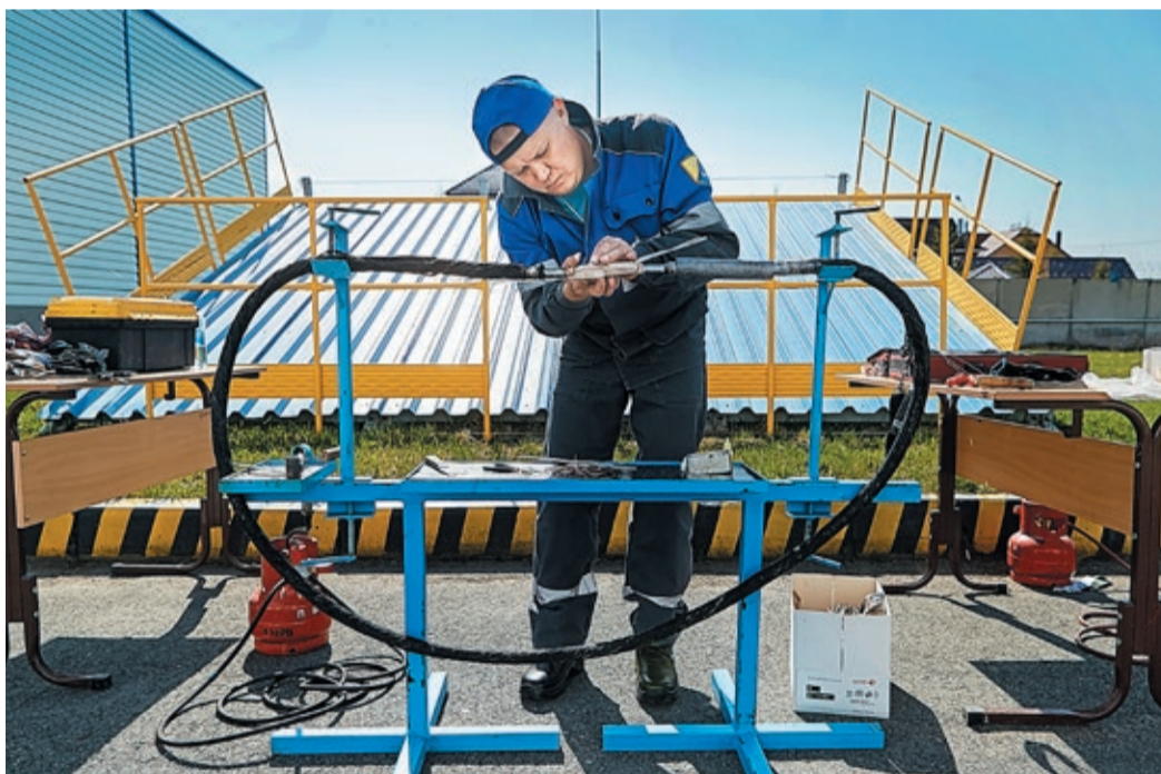
Участникам нужно точно и оперативно срastить 16-жильный кабель и защитить соединение свинцовой муфтой
