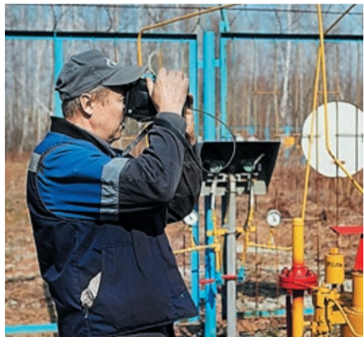
Начинается и заканчивается работа проверкой загазованности
