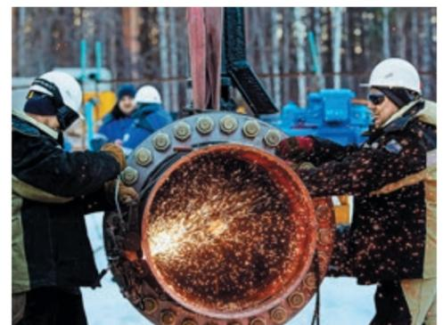
Точная подрезка краев позволит установить узел с первой попытки
