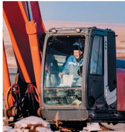
Машинист экскаватора начинает и заканчивает огневые
