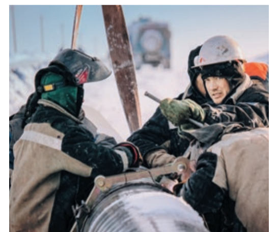
Крепкий стык — результат работы монтажника и сварщика
