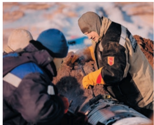
Порою, чтобы отремонтировать трубу, изоляцию надо снять
