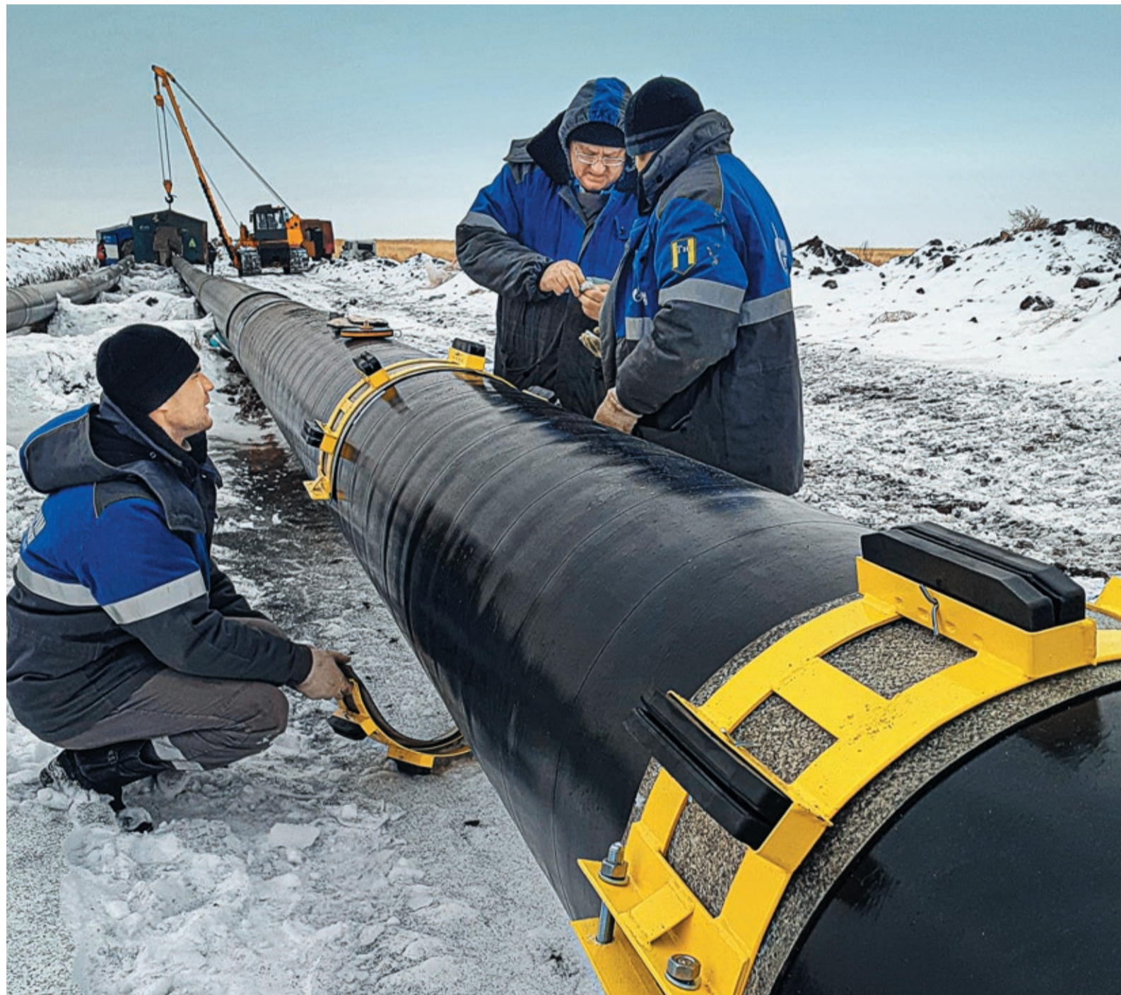
Когда на трубу надевают направляющие устройства, это означает, что до полной готовности перехода под автодорогой остается один шаг
