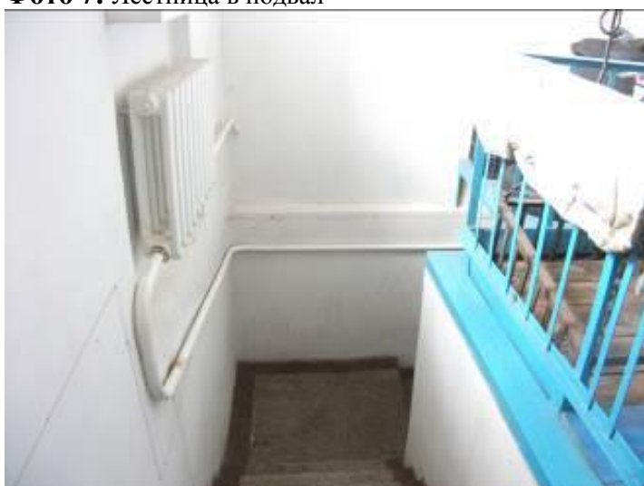
Фото 7: Лестница в подвал
