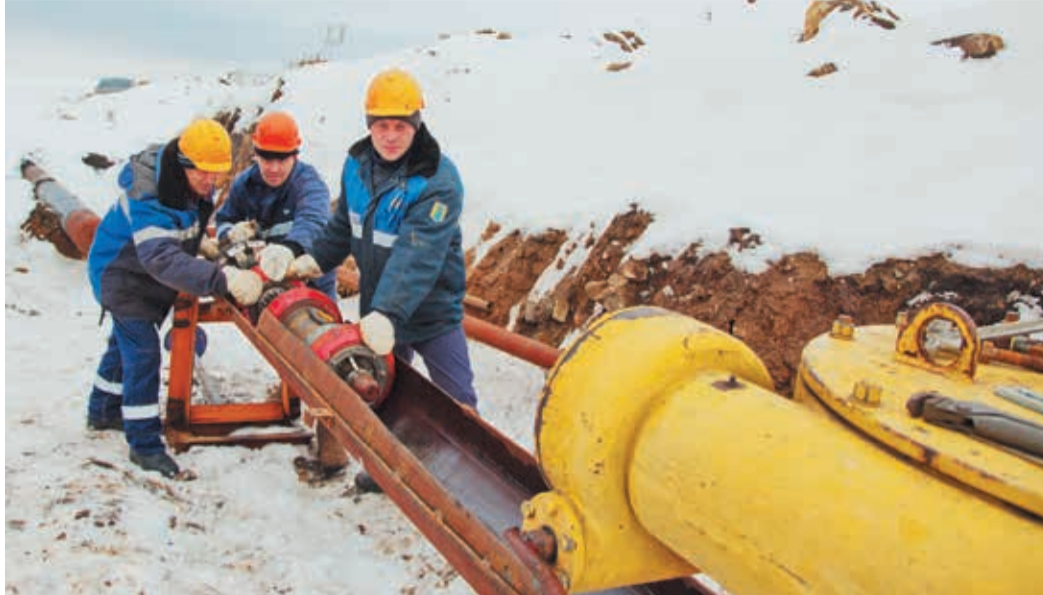
Сперва линтубы обцими усилиями двигают снаряд-дефектоскоп по желобу к камере запуска
