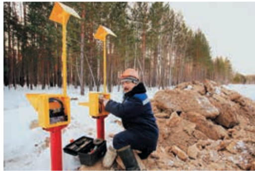
Для поддержания работоспособности системы активной защиты работники ЛПУ и УАВР выполняют регулярные обследования и ремонт объектов ЭХЗ
