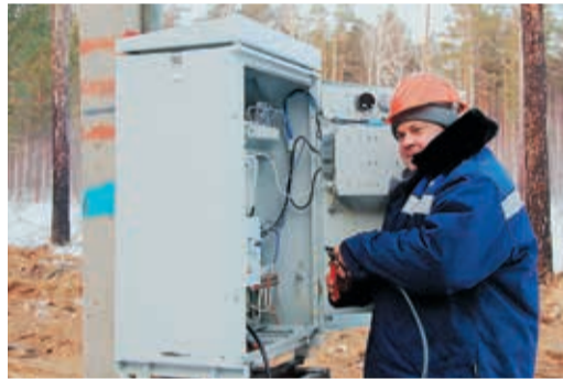
Для поддержания работоспособности системы активной защиты работники ЛПУ и УАВР выполняют регулярные обследования и ремонт объектов ЭХЗ
