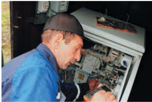
Для поддержания работоспособности системы активной защиты работники ЛПУ и УАВР выполняют регулярные обследования и ремонт объектов ЭХЗ
