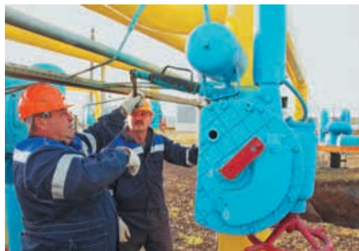
Чтобы набить кран смазкой, нужно 5-6 таких шприцев
