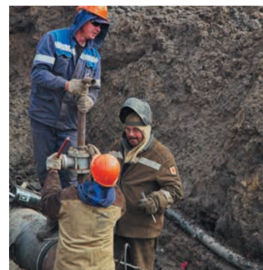
Заглушка уже приварена — осталось собрать байпас
