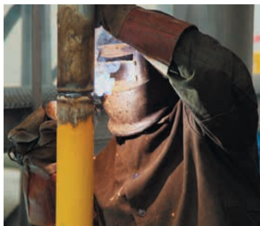
Виктор Конев срачивает две части байпасного вывода
