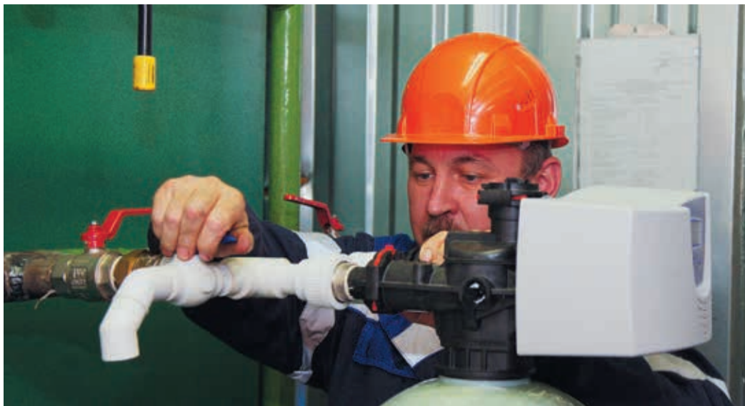
Владимир Пономарев выполняет обвязку новой установки химводоочистки
