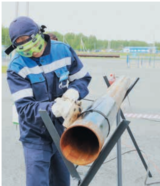
Линар Зулкарнаев с ГКС-16 впервые в жизни наносит термоусадочную манжету
